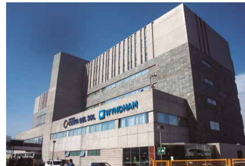
El Hotel Costa del Sol, en el aeropuerto Jorge Chávez, fue construido por el grupo EOM.
